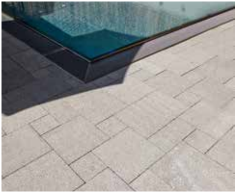
▲ Alp-Granit Bodenplatten „OPUS-ANTIK“-Verlegung im römischen Verbund
